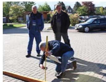
Vermessung der Spurrillen auf dem Vorplatz in Heide
