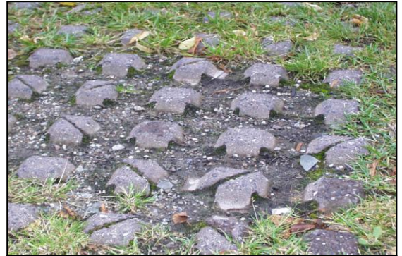
Negatives Rasengitter erhöht die Stolpergefahr
