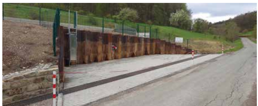
Abbildung 1: Fahrzeugaufstellfläche vor einem Feuerlöschteich am Hang
