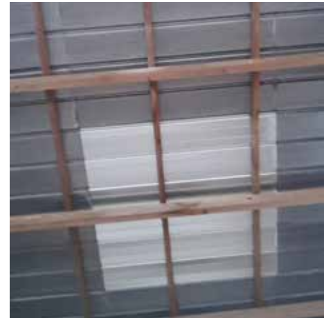
Dach mit Lichtplatte von unten
