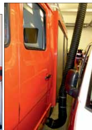
Keine Verkehrswege: Durch die Überbelegung der Fahrzeughalle stehen die Fahrzeuge zu eng.
