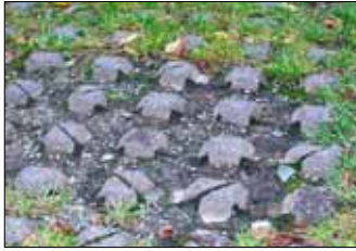
Stolperstein: Negatives Rasengitter erhöht die Stolpergefahr
