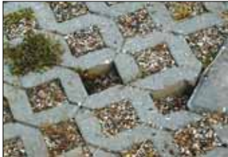
Umknickgefahr: Löcher im Rasengitter
