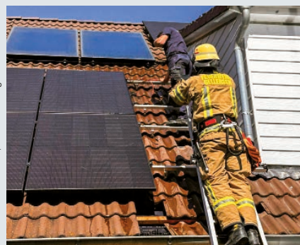
Fachleute erforderlich: Gemeinsam mit einem Fachbetrieb wurden die Solarmodule kontrolliert und anschließend entfernt.
