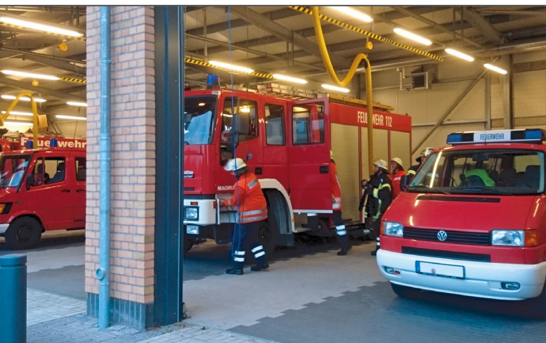
Beleuchtung der Verkehrswege in der Fahrzeughalle
